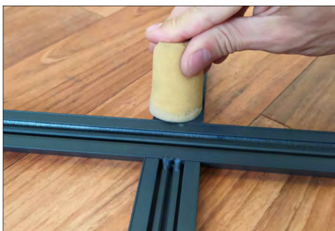
2) Pulizia della superficie alluminio con alcool isopropilico LCALCOL-IP
