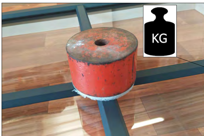
9) Tenere l'anta in posizione orizzontale con l'applicazione di un peso soprattutto negli incroci tra sprossen per favorire il corretto incollaggio
