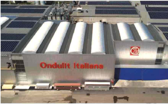
Stabilimento Ondulit Cisterna di Latina
