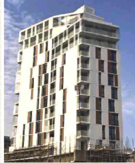
Rivestimento facciata ventilata
